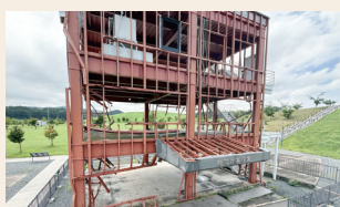
南三陸町防災対策庁舎
