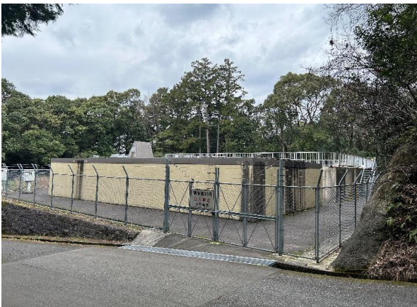
雉子ヶ尾高区配水池
