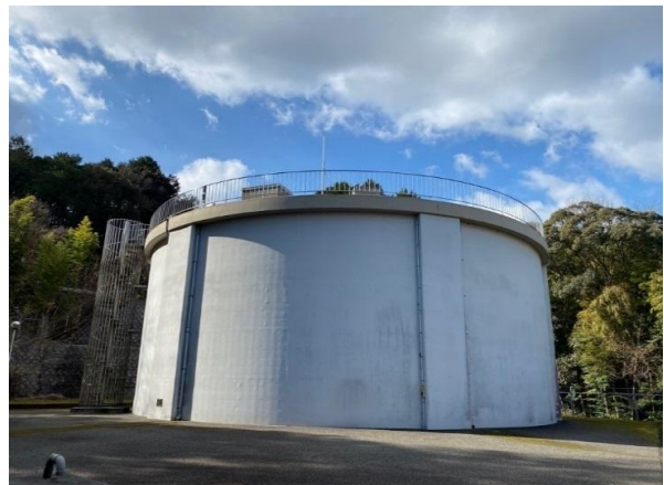
牛頸高区配水池
