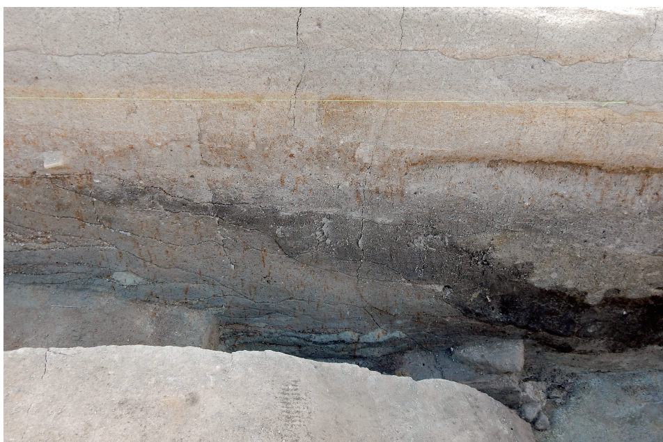
(2) 1トレンチ 西壁下成土層 （東から）
