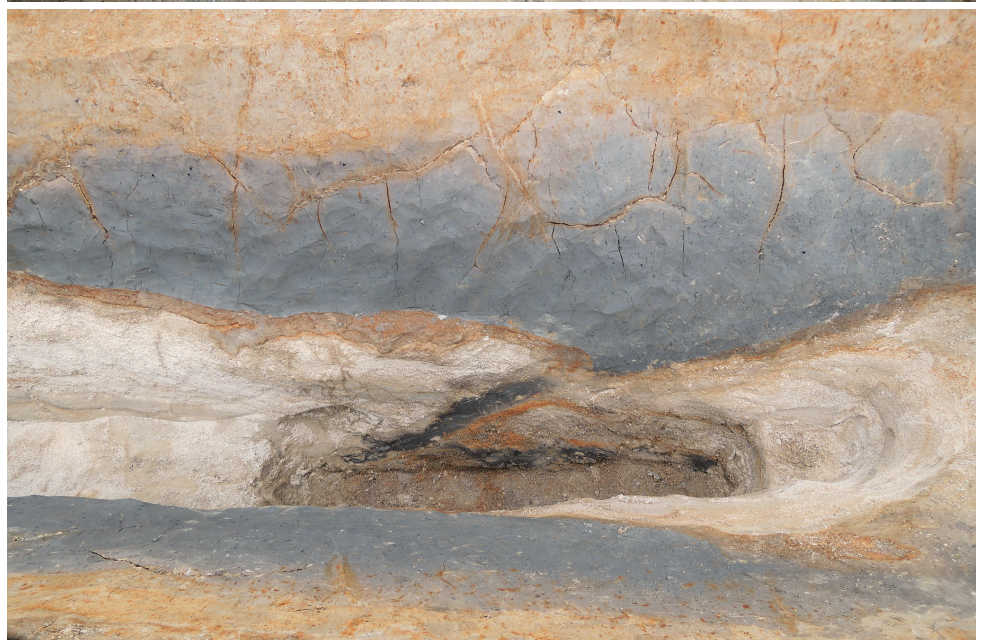
(3) 4トレンチ土層 (西から)
