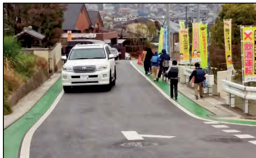
写真:交通安全施設整備(カラー塗装)
