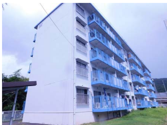
中層耐火5F（ベランダ側）
