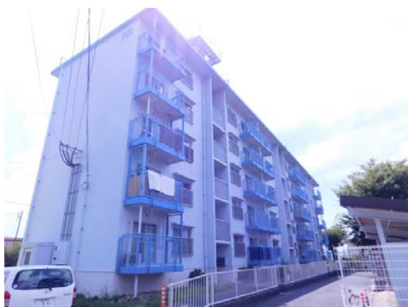
中層耐火5F（玄関側）
