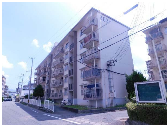
中層耐火5F (玄関側)
