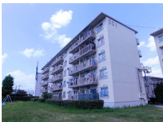
中層耐火5F (ベランダ側)
