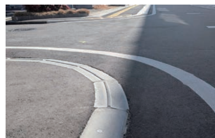
【福岡市モデルの境界ブロック】 中央に高さ5mmの突起がある
