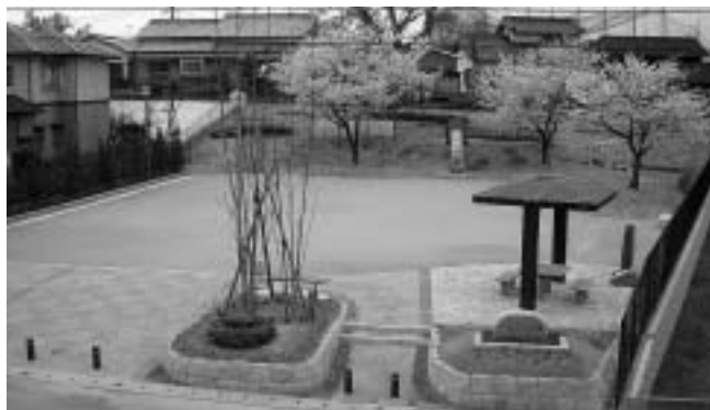
かまぶた公園 着工後
